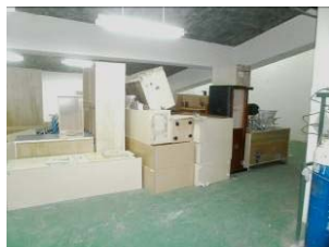
氣體機房雜物
