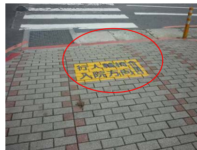
設置斜坡坡道及指引標示
